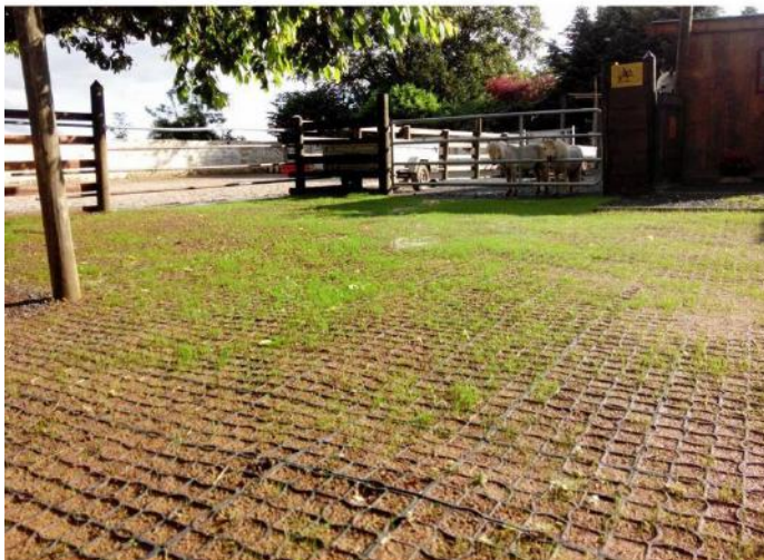
Exemples de parc stabilisé à l'aide de dalle anti boue Coût approximatif du projet : 9000€
